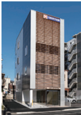
川崎信用金庫 南太田支店 鉄骨造 地上4階
