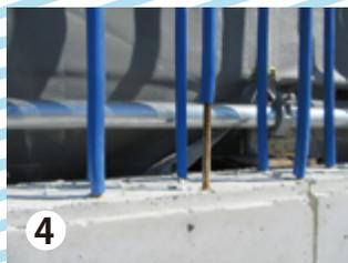
①朝礼の様子です。3階床型枠工事がメインの工程となるため、型枠大工の川端工務店さんから5名が参加しています②パイプ自体の強度を強化し、なおかつ軽量化のため、見慣れた丸型ではなく多角形を採用しています③現場事務所にて、業者さんとユニットバスの打合せです。仕様や搬入日の確認をしていました④建物外回りの擁壁配筋の差筋に、青いゴムチューブで養生しています。見た目が良くなるだけでなく、サビ防止にも効果抜群です
