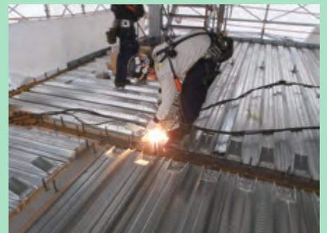
鉄骨造は、先に梁と柱をクレーン車を使い建て込みます。その後、鉄骨同士を仮固定し歪みがないか確認し本締めを行います。そしてデッキ(床)を設置し、生コンを打ちます。壁(ALC)を設置して上棟となります。
