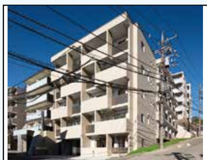
(仮称)鷺沼マンション新築工事
