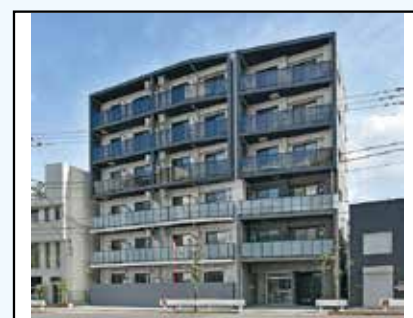
(仮称)藤崎3丁目マナカマンション新築工事
