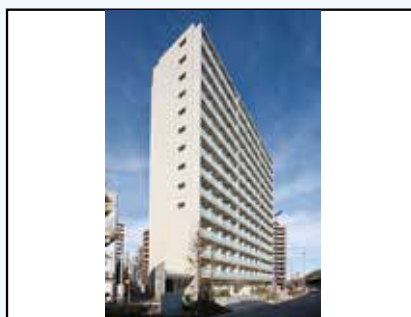
(仮称)川崎区堀之内町マンション新築工事
