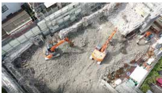
小川組旧本社解体工事の様子
