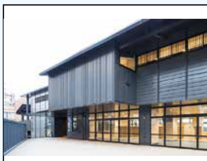
城南小学校校舎・幼稚園園舎改築工事
