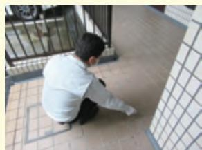
③共用廊下から外構など点検します。タイルの打診検査やヒビ割れ、シーリングの劣化具合などを点検します。
