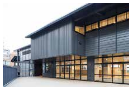
城南小学校・幼稚園外構整備その他工事 [東急・小川JV]
