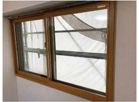
After写真 (内側にもう一つサッシが追加されました)
