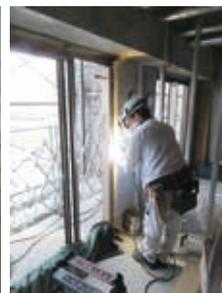
②窓のサッシだけでなくSDも設置していきます③サッシを溶接で固定しています。火気を使用しますので消火器も設置します
