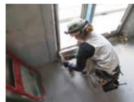
①レーザーレベルで測り数ミリのズレも起きないようにサッシを固定していきます
